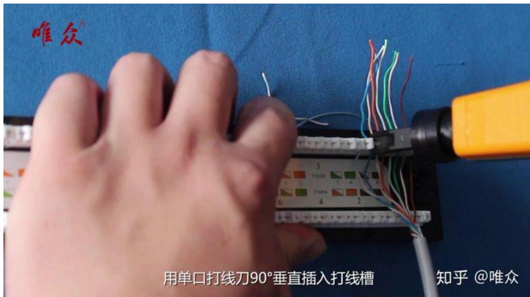
图 1 将线对逐次压入槽位并打压固定
