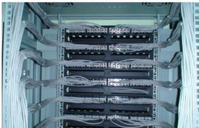
图 3 模块化配线架端接后机柜内部示意图
