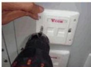
图 5 安装信息面板
