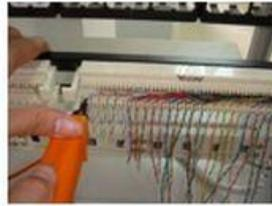
11. 用准备好的单用打线刀逐条压入并打断多余的线
